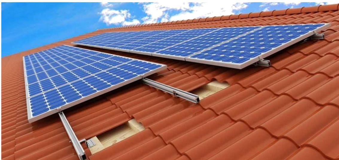
O perfil é de alumínio anodizado. Todos os perfis fornecidos possuem 2,22 metros de comprimento. A fixação do suporte de telhado será através do canal lateral do perfil, já a fixação dos grampos, é feita no canal superior do perfil.
